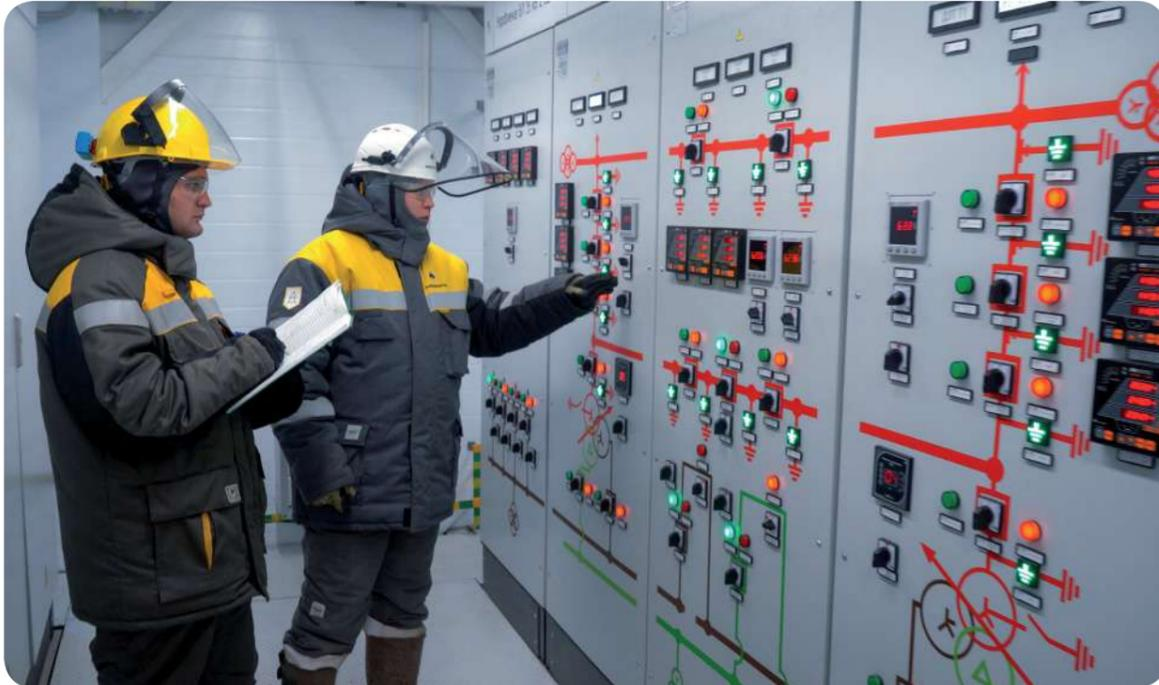
«Самотлорнефтегаз», один из крупнейших добывающих активов «Роснефти», запустил на промысле новую электрическую подстанцию. Её мощность составляет 2х40 МВА, класс напряжения – 110/35/6кВ.
